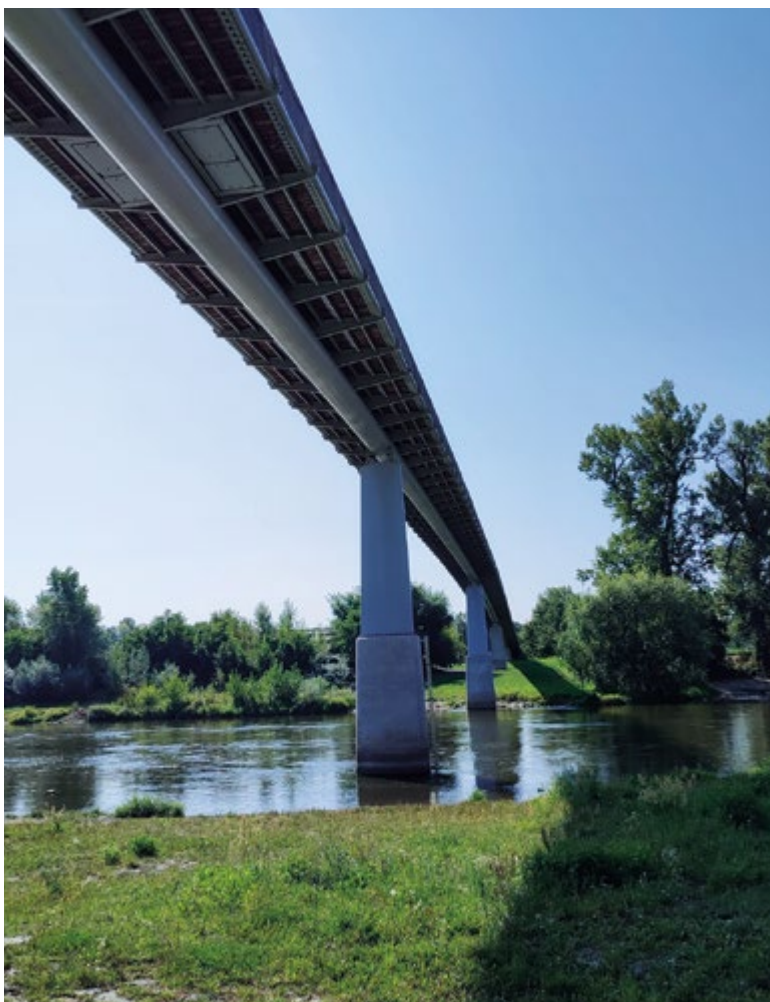
Obr. 2. Kontrolní profil Vltava – Trojská lávka (zdroj: Mapy.cz) Fig. 2. Vltava control profile – Trojská lávka (source: Mapy.cz)
