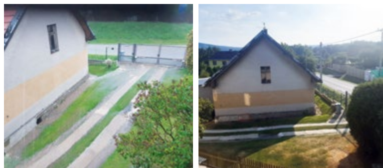
Obr. 5. Situace pod hlavní silnicí v obci Drahlín v lokalitě čp. 121 a 122 při přívalové povodni v červnu 2024 v porovnání s běžnou situací na konci srpna téhož roku
