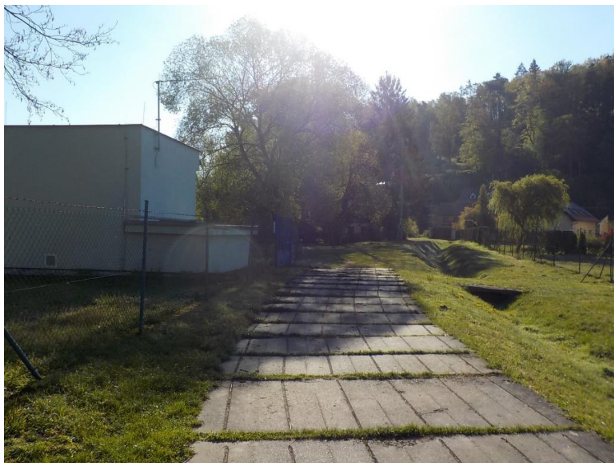
Obr. 6. Objekt jímání podzemní vody v Tupadlech v povodí Liběchovky Fig. 6. Groundwater abstraction facility at Tupadly in the Liběchovka catchment
