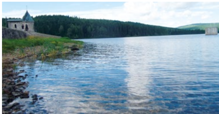
Obr. 3. Vodní, později vodárenská nádrž Souš, vybudovaná v roce 1915 v údolí Černé Desné. Po katastrofě přehrady na Bílé Desné byla její hráz ve 20. a 70. letech minulého století rekonstruována; červen 2012 (Foto: D. Vondrák)
