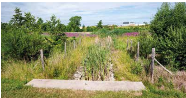
Obr. 4. Poldr chrání Němčany před povodněmi – v popředí vpust do vodní nádrže (Zdroj: Nadace Partnerství – Adaptterra Awards, foto: V. Herout)
