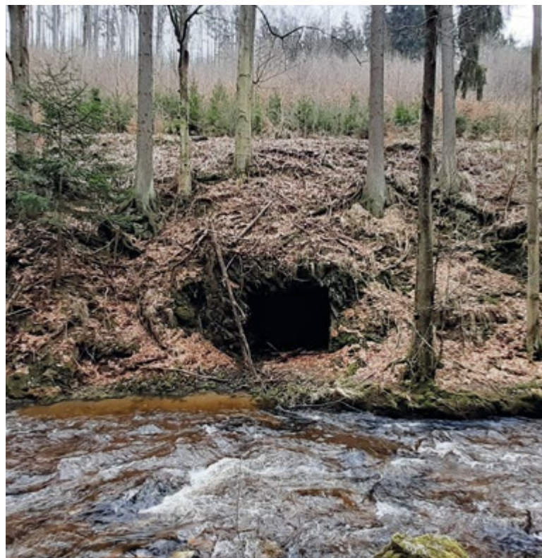
Obr. 3. Vyústění průzkumné štoly v údolí Zdobnice (LAPV Pěčín)
