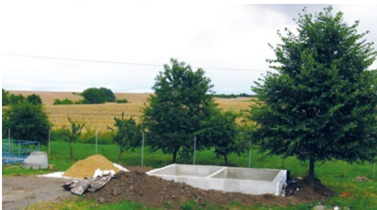
Obr. 3. Příklad výstavby základní konstrukce dvou RB jednotek pro zajištění střídavého provozu napouštění, odvodnění a stabilizace kalu z usazovací nádrže kořenové ČOV, Česká republika
