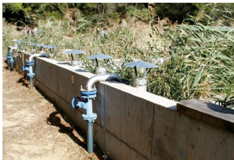
Obr. 1. RB jednotka s řízeným systémem napouštění kalu a ventilace, ČOV s SBR reaktorem, Francie
