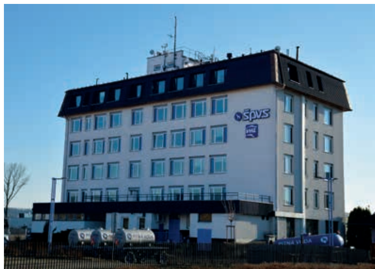
Obr. 12. Pohled na budovu správy VHZ a ŠPVZ s dispečinkem, laboratořemi a zázemím pro servisní techniku (březen 2022, A. Létal)
